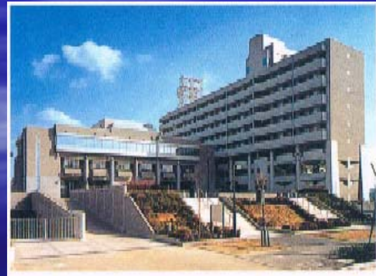
立川地域防災センター
