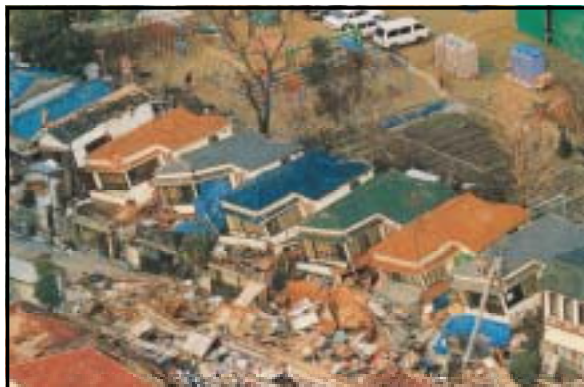
将棋倒しとなった住宅地 (神戸市東灘区)
