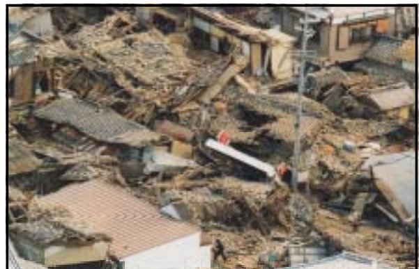
避難経路の確保も困難 (淡路島北淡町)
