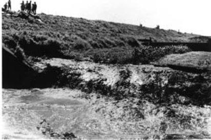
川裏法面漏水増大
