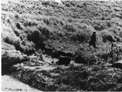
川裏法面漏水(泥水)
