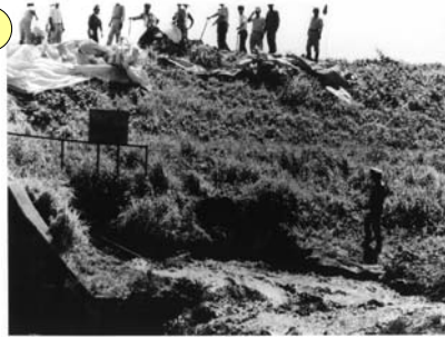
川裏法面漏水増大
