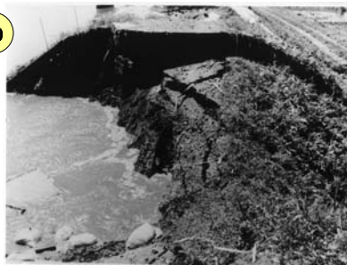
川表法面陥没増大、堤防全体が陥没始まる
