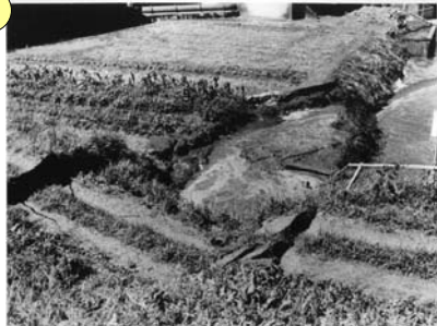
川裏法面陥没
