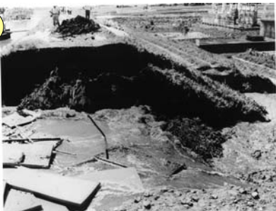
洪水流が堤内地へ流入
