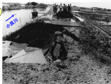
川表法面陥没増大
