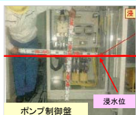
ポンプ場の浸水状況 (平成18年九州南部豪雨: 川内川)
