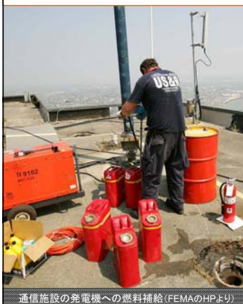
通信施設の発電機への燃料補給(FEMAのHPより)
