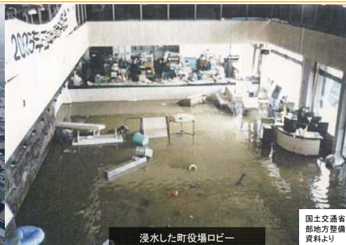
浸水した町役場ロビー
