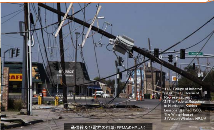
通信線及び電柱の倒壊(FEMAのHPより)
