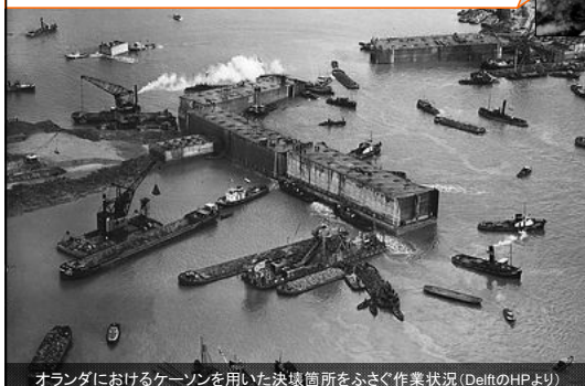
オランダにおけるケーソンを用いた決壊箇所をふさぐ作業状況 (DelftのHPより)
