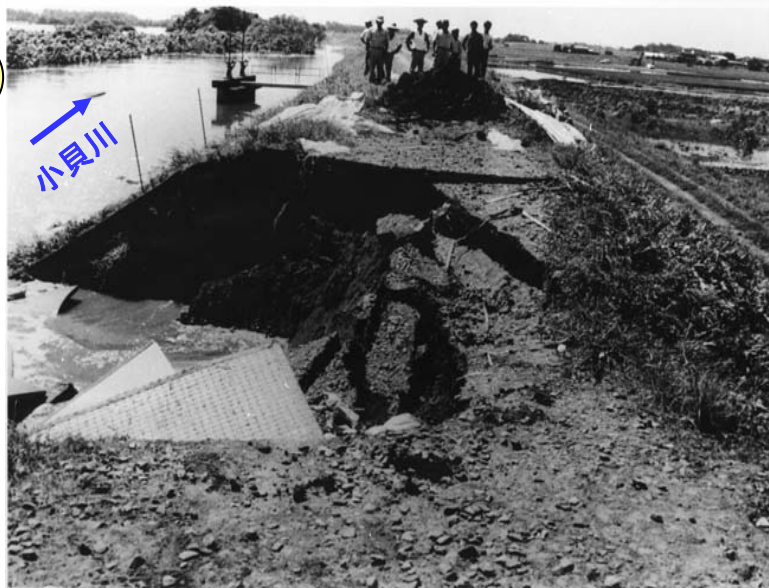
川表法面陥没増大
