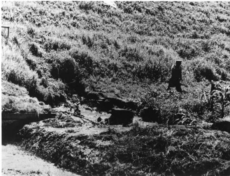
川裏法面漏水(泥水)
