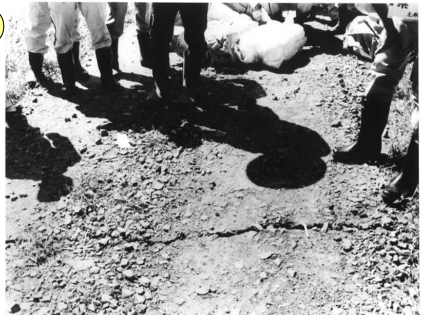
堤防天端クラック
