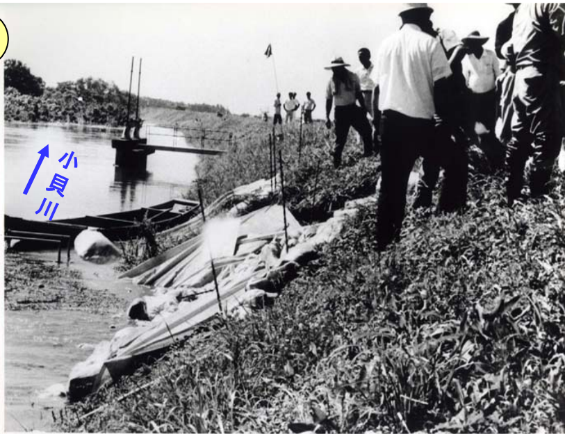
川表法面陥没
