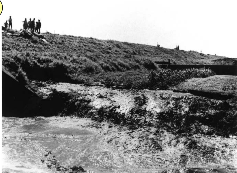
川裏法面漏水増大
