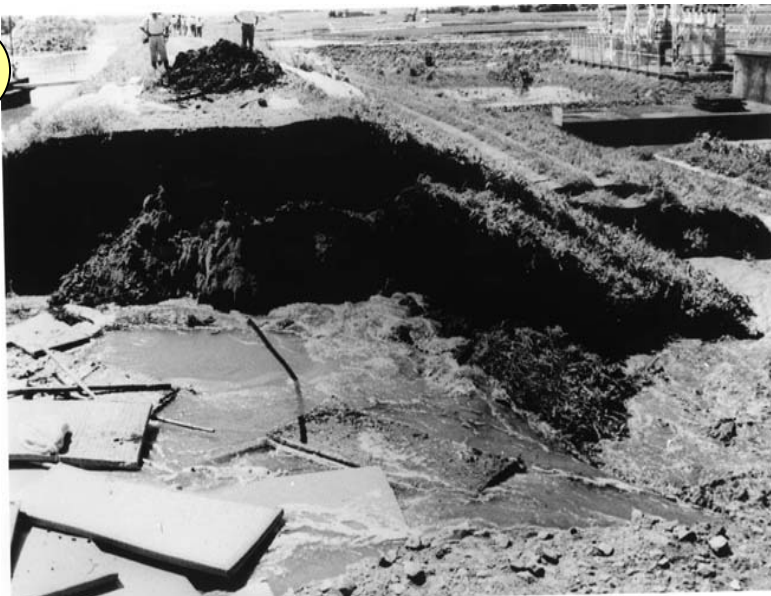
洪水流が堤内地へ流入
