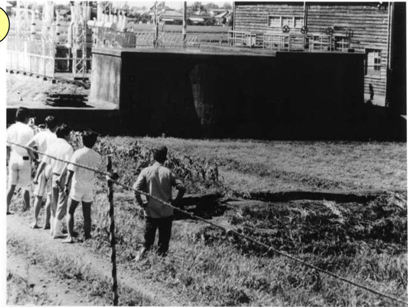
川裏下流側から漏水
