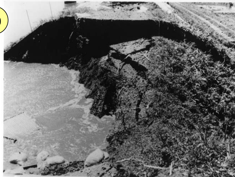
川表法面陥没増大、堤防全体が陥没始まる
