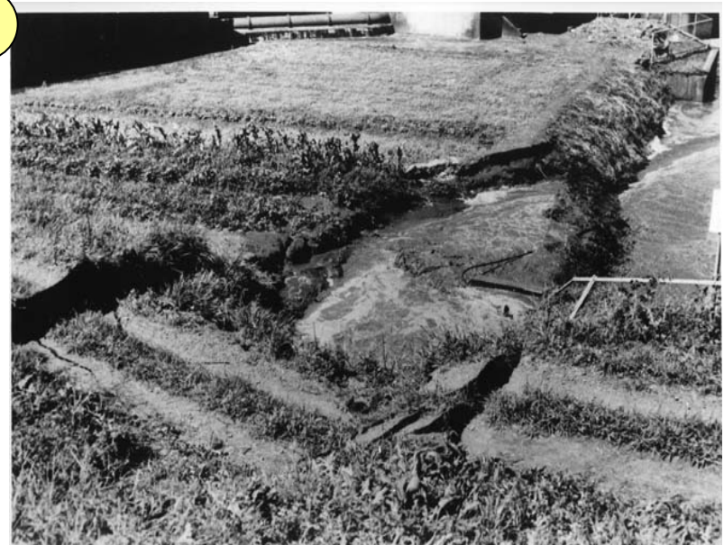
川裏法面陥没
