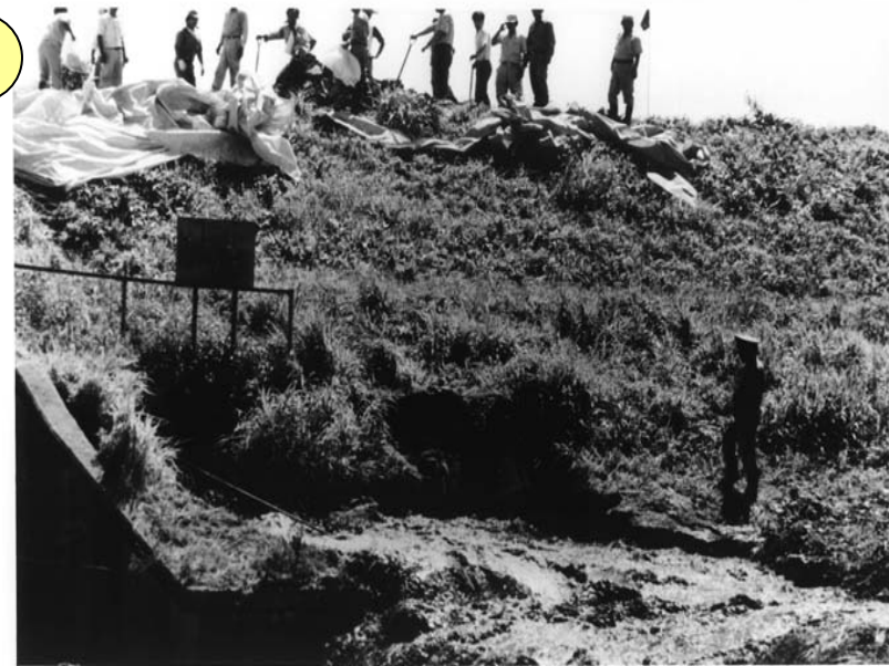
川裏法面漏水増大
