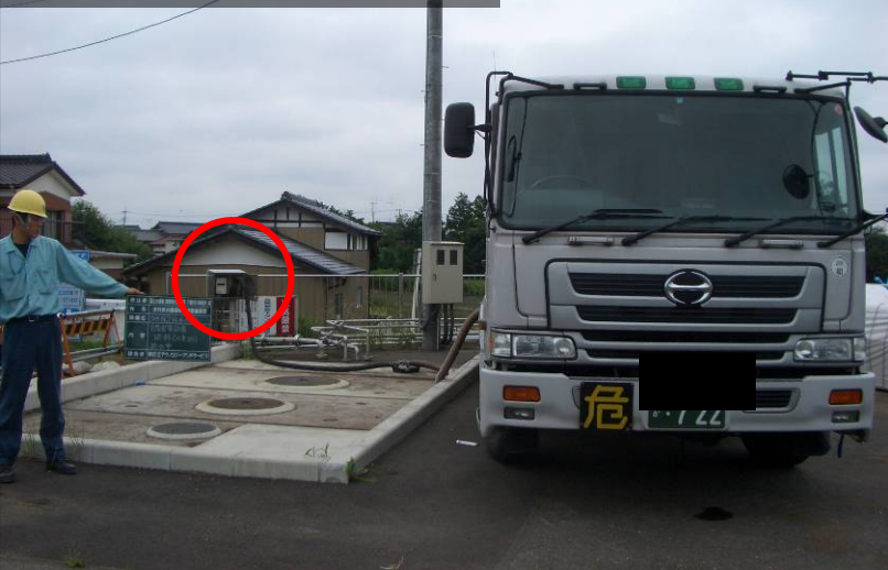
排水ポンプ場の給油状況
