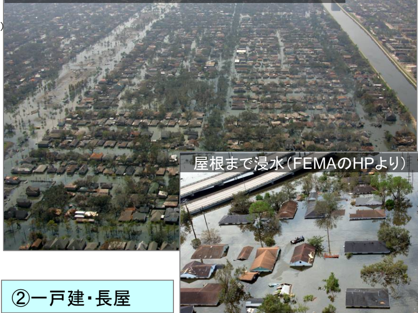
ニューオリンズ市の浸水地域(FEMAのHPより)
