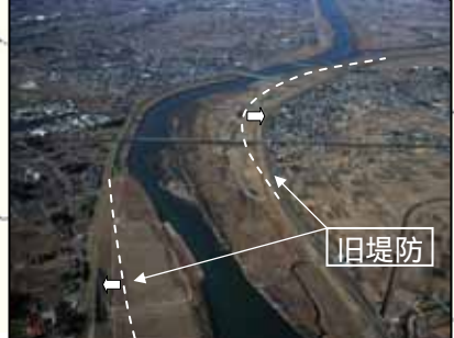
渡良瀬川合流点下流部の引堤
