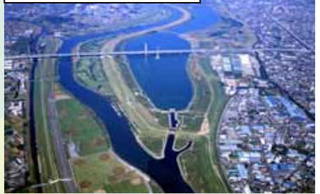
荒川第一調節池
