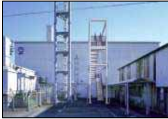
NTT局舎屋上避難所
