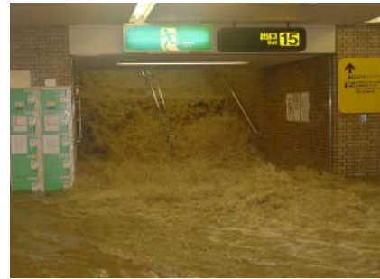
平成15年7月福岡水害による地下施設の浸水状況
