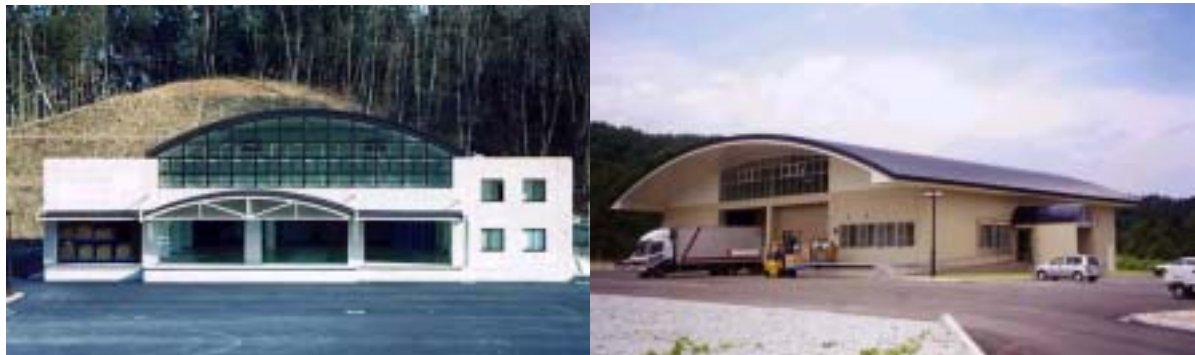
既設広域防災拠点【左：西播磨広域防災拠点、右：但馬広域防災拠点】
