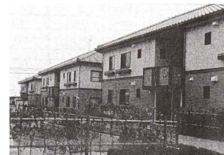
応急仮設住宅と並行して 公営住宅を供給
