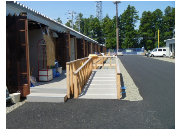
住戸前の舗装、スロープの設置
