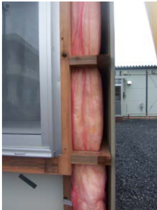
追加工事による 外断熱
