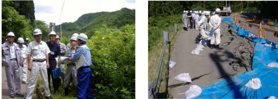
図 8-1-3 岩手・宮城内陸地震における道路復旧技術指導の様子
