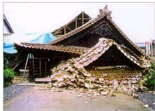
図 2-9-3 出雲大社上道協会の崩壊の様子
