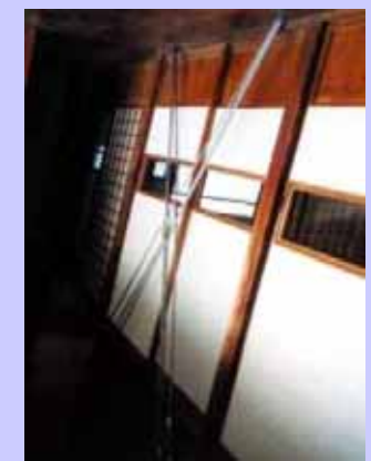
耐震補強工事の一例
