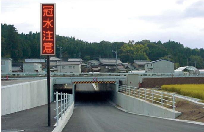
大雨時の通行車両の安全性確保のため、アンダーパス内の冠水状況を自動的に(センサー)に検出し、水位に応じた冠水情報を表示。
