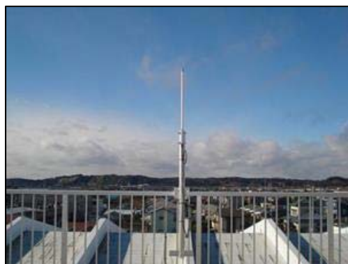
情報用アンテナの設置
