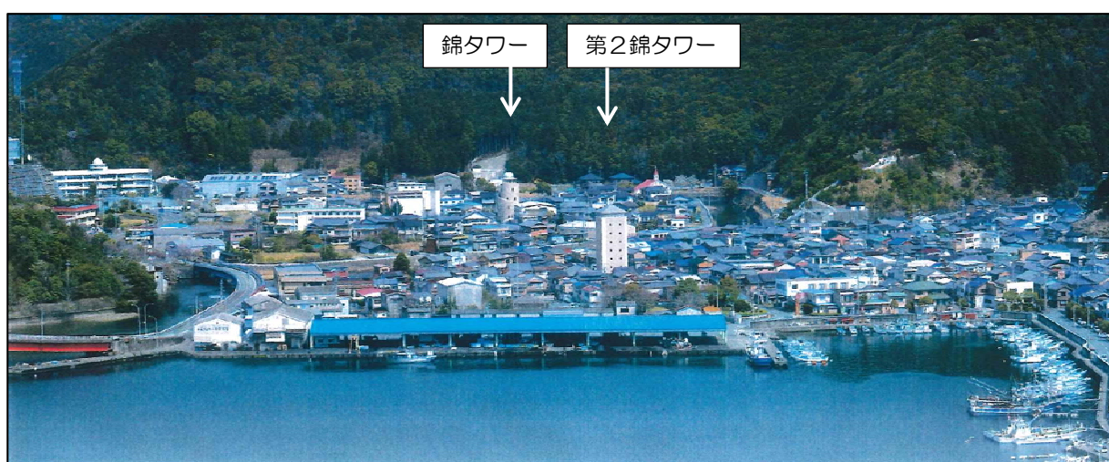
海から見た大紀町錦地区（錦タワー、第2錦タワーが見える）
