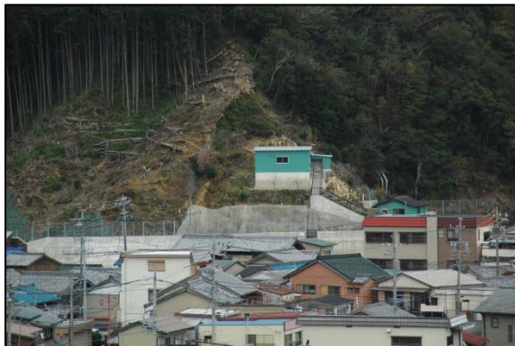
高台に設置された避難所(緑の建物)
