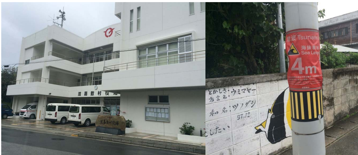
渡嘉敷地区唯一の津波避難所（村役場）
