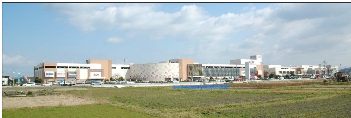
大規模商業施設であり避難拠点でもある日吉津
