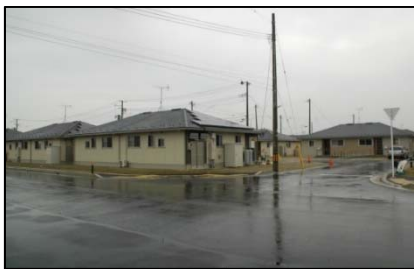
新山下駅周辺の工事中的の新市街地
