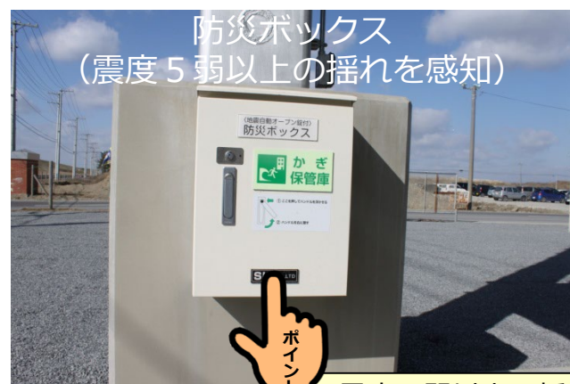
津波避難タワー入口部 (ケイ酸カルシウム製の破壊可能なドア)
