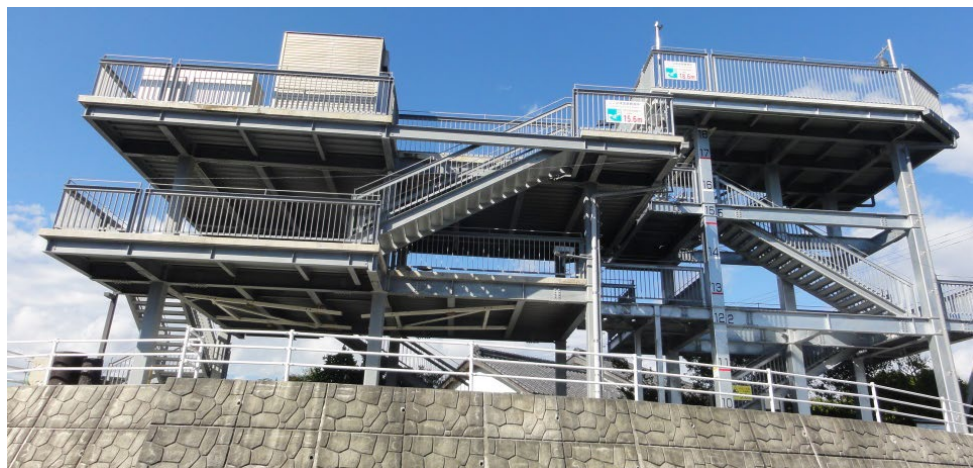
津波避難タワー外観
