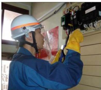
<漏電の確認作業の例>
