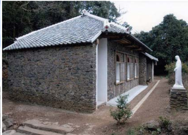
大野教会堂(長崎県長崎市) :木造(ド・ロ壁)・棧瓦葺
