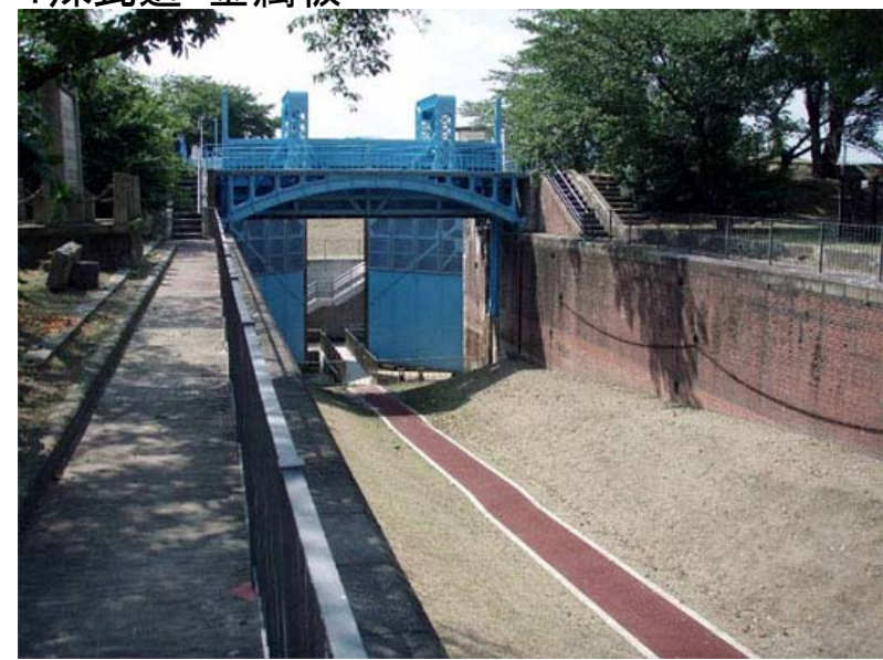
淀川旧分流施設（大阪府大阪市）
