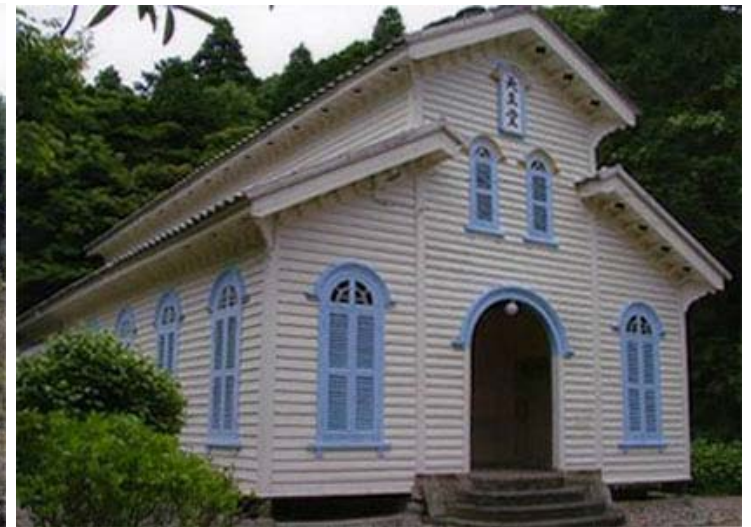
江上天主堂(長崎県五島市) :木造・棧瓦葺
