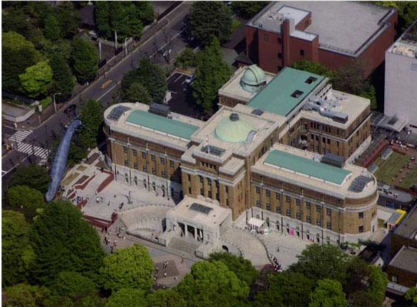
旧東京科学博物館（東京都台東区） ：SRC造+RC造・陸屋根
