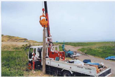
図1 ジオスライサーによる地層採取作業
