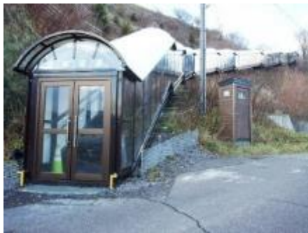
シェルター付き避難階段設置例 (北海道礼文町)
