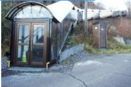
シェルター付き避難階段設置例（北海道礼文町） 出典）富安（株）マルエイ三英事業部ウェブページ
