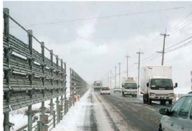
吹き払い柵の設置による 通行障害の緩和
