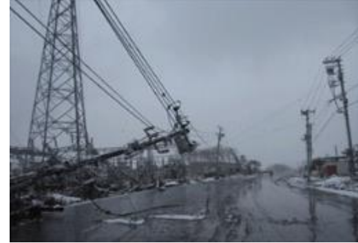
東日本大震災における電柱の転倒 出典) 国土交通省ウェブページより
