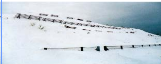
雪崩予防柵(雪崩の発生を未然に防ぐための工法)
