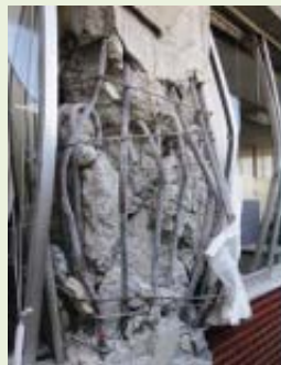
出典:国土技術政策総合研究所、建築 研究所 平成23年4月4日 「白河市、須賀川市、仙台市におけるRC造、 S造、非構造部材を中心とした建築物被害調 査(速報)」
