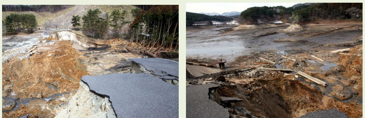
(出典) 須賀川市ホームページ「須賀川市内における被災状況」
