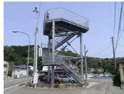
津波避難タワー(静岡県沼津市)
