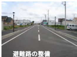
避難路の整備
