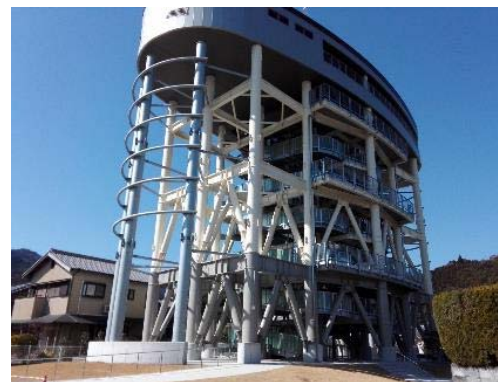
津波避難タワーの整備 (黒潮町)
