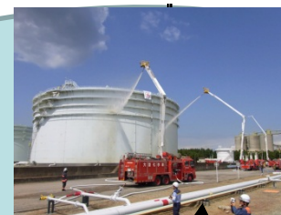
屋外給水設備に 消防車のホース を接続
