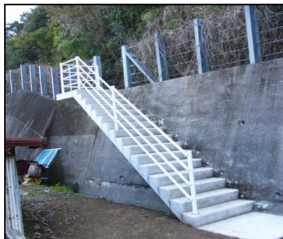
急傾斜地擁壁避難路設置 (県事業)
