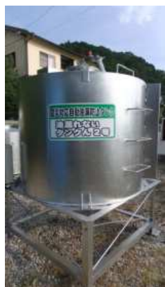
流出防止装置付き 重油タンク
