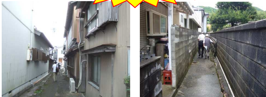
〈倒壊の危険性がある家屋〉
