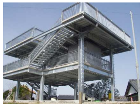
〔津波避難タワー〕
