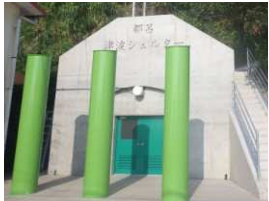
〔津波シェルター：H28.8完成〕
