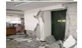
(※)東日本大震災後のA市役所の損傷状況
