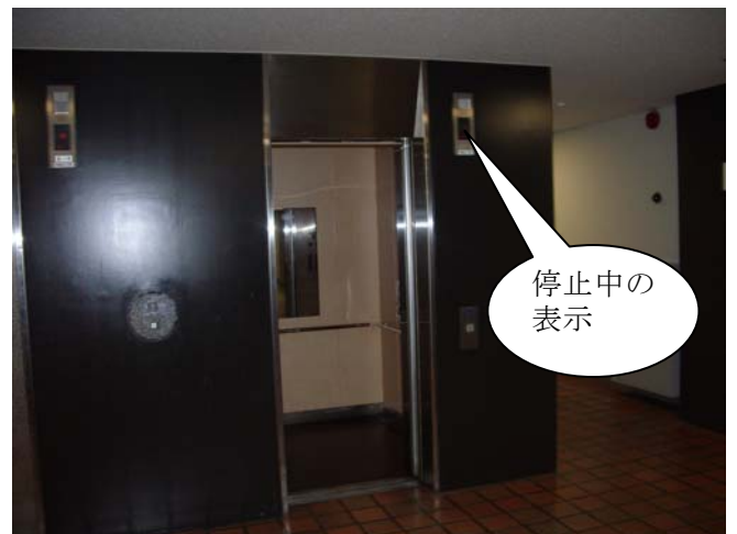
訓練時の状況②（エレベーターは、監視員による最寄り階への停止操作も合わせて実施）
