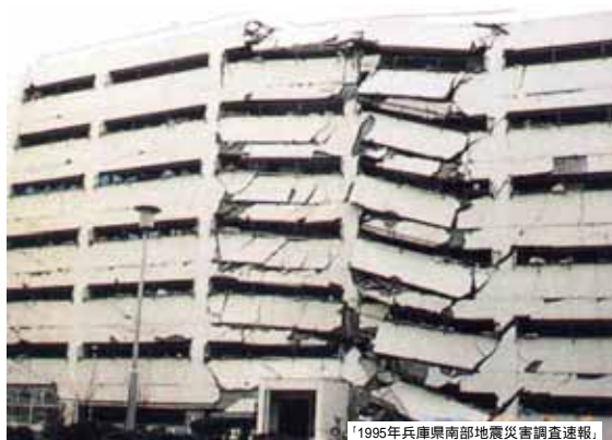
一見して住家全部が倒壊している例
