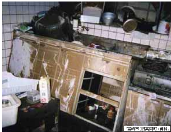
台所の流し台:転倒し、配管が切れている
