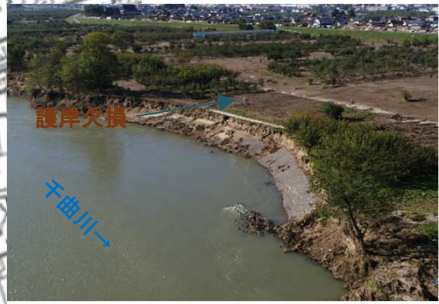
⑥護岸欠損 11月2日 9:20撮影
