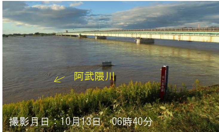
あぶくま 阿武隈川下流 阿武隈橋(8.1k付近) あぶくま 宮城県岩沼市阿武隈地先
