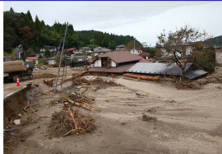
▲ 家を埋めた流出土砂（宮城県丸森町）
