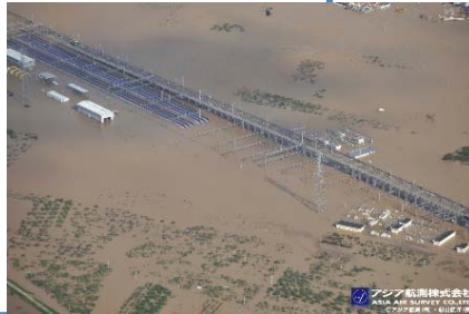
北陸新幹線車両基地 浸水状況
