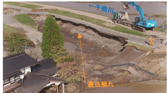
②決壊地点下流側の裏法崩れ 10月20日 16:00撮影
