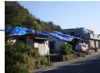
住宅の被害写真(鋸南町岩井袋地区)
