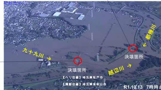
荒川水系 越辺川左岸7.6k付近
