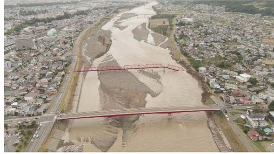
千曲川の堤防欠損、落橋の状況
