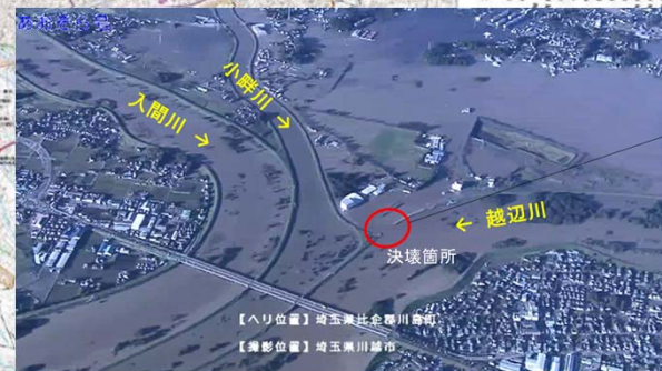
荒川水系 越辺川右岸0k付近
