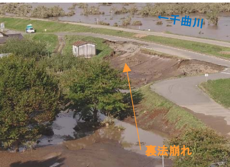
①決壊地点下流側の裏法崩れ 10月13日 14:00撮影
