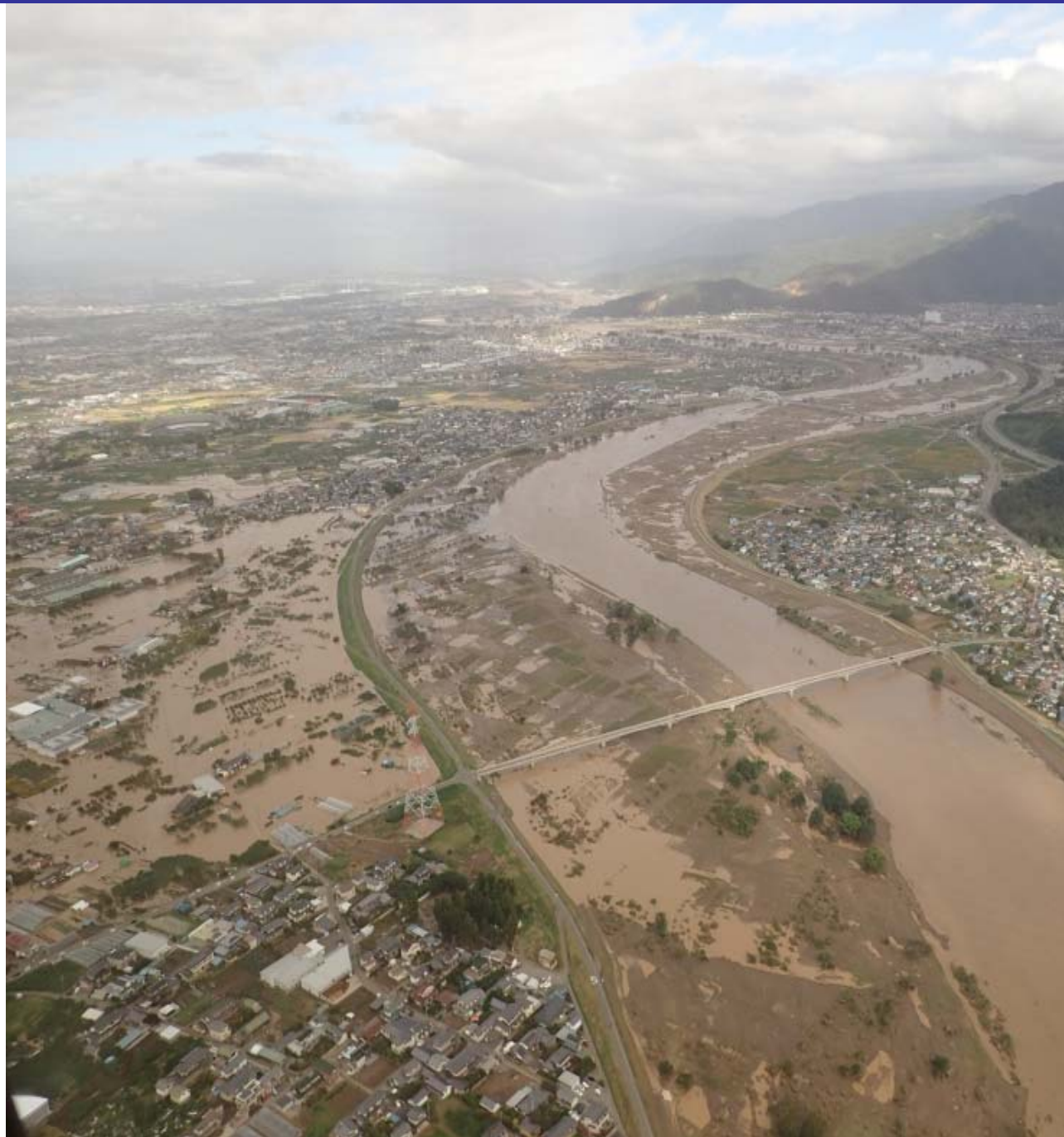
▲ 千曲川の氾濫による浸水被害 (長野県長野市)
