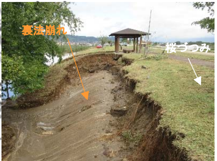
⑤裏法崩れ 10月13日 9:50撮影
