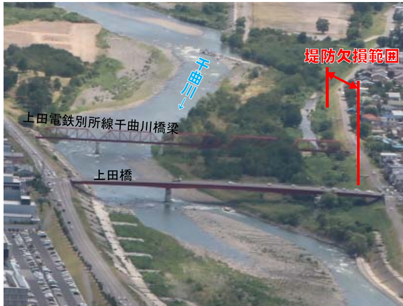
図-1 台風第19号出水前の状況
