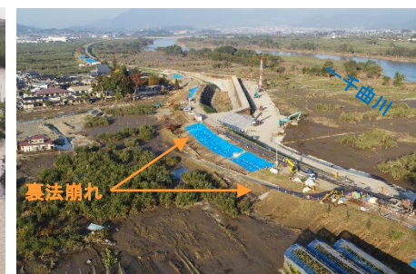
④決壊地点上流の裏法崩れ 10月31日 15:40撮影
