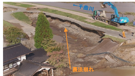
②決壊地点下流側の裏法崩れ 10月20日 16:00撮影
