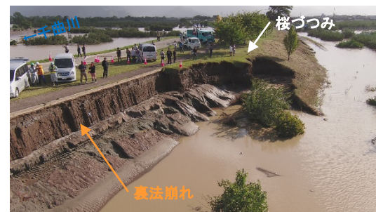
③決壊地点上流の裏法崩れ 10月13日 14:50撮影
