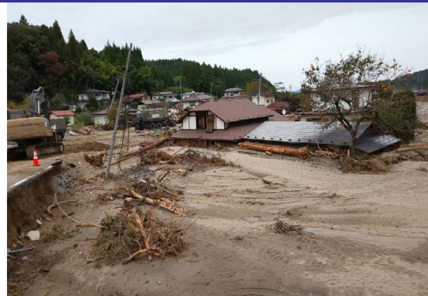
▲ 家を埋めた流出土砂 (宮城県丸森町)
