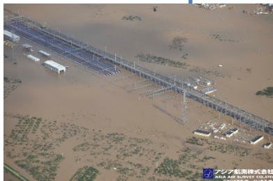
北陸新幹線車両基地 浸水状況
