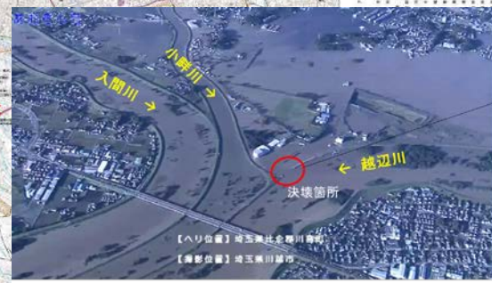
荒川水系 越辺川右岸0k付近
