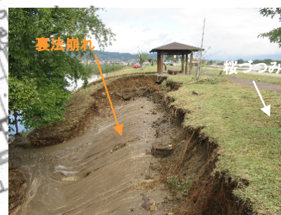
⑤裏法崩れ 10月13日 9:50撮影
