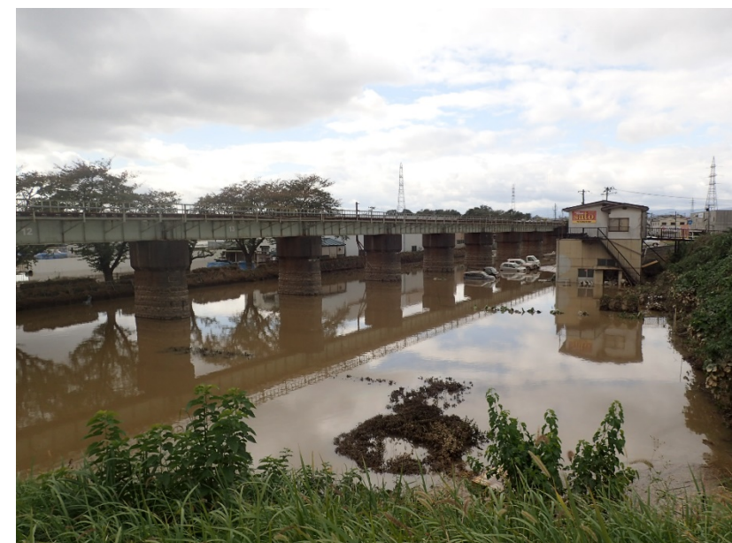
▲ 家屋や車両の浸水被害 (福島県郡山市)
