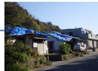
住宅の被害写真(鋸南町岩井袋地区)
