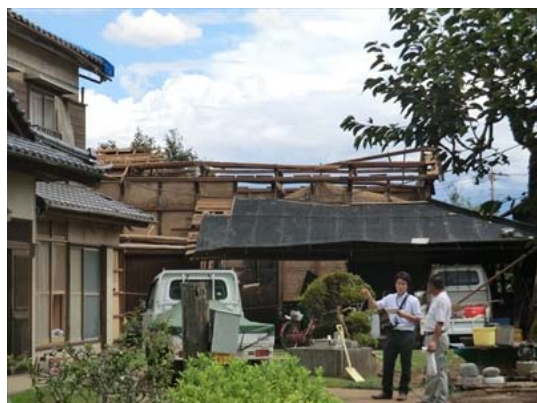
写真7 小屋組の被害（野田市）
