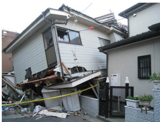
写真2 上部構造の倒壊（越谷市）
