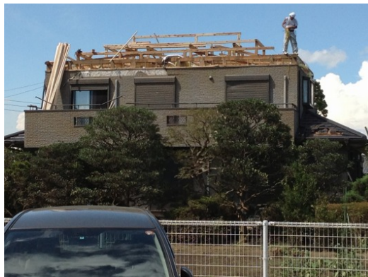
写真6 小屋組の被害（野田市）
