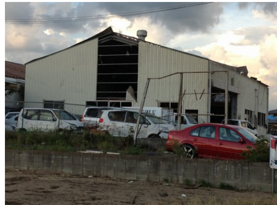
写真14 外壁材の飛散（松伏町）
