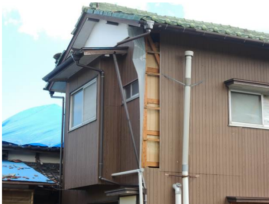
写真13 外壁材の剥離（越谷市）
