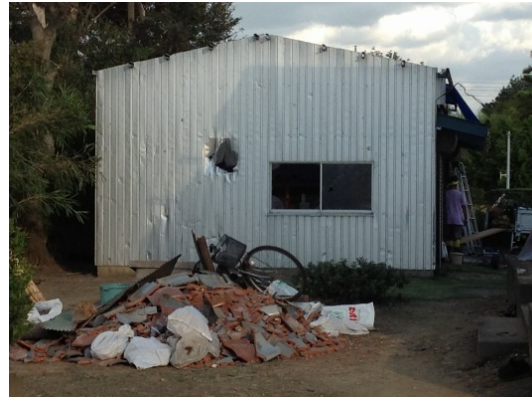
写真19 飛来物による衝突痕（越谷市） 写真20 飛来物による衝突痕（松伏町）
