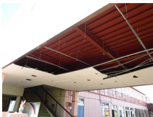
写真18 ピロティ軒天井の脱落（越谷市）
