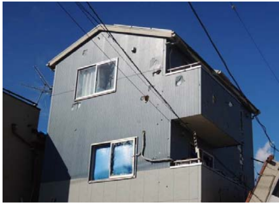
写真19 飛来物による衝突痕（越谷市） 写真20 飛来物による衝突痕（松伏町）
