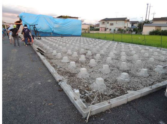
写真4 写真3に示す上部構造の基礎
