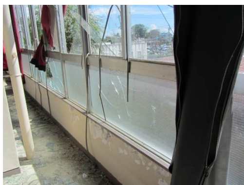
写真17 ガラス窓の破損（越谷市）
