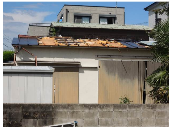
写真12 カラー鋼板の飛散（越谷市）
