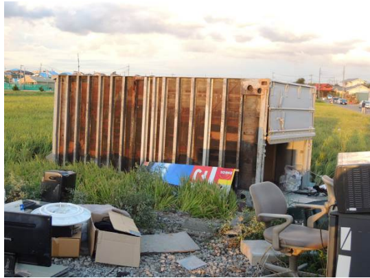
写真25 鋼製コンテナの転倒（越谷市） 写真26 フェンスの倒壊（越谷市）
