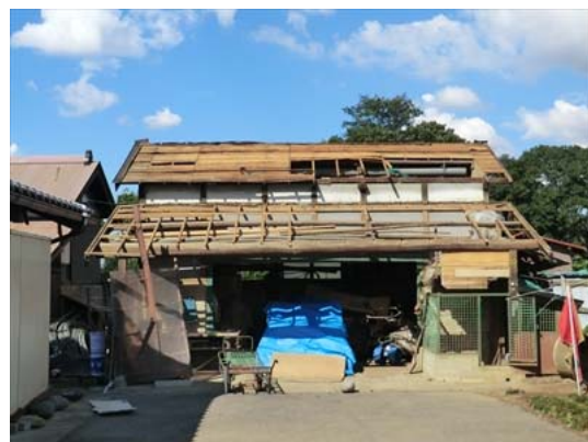
写真8 小屋組の被害（野田市）
