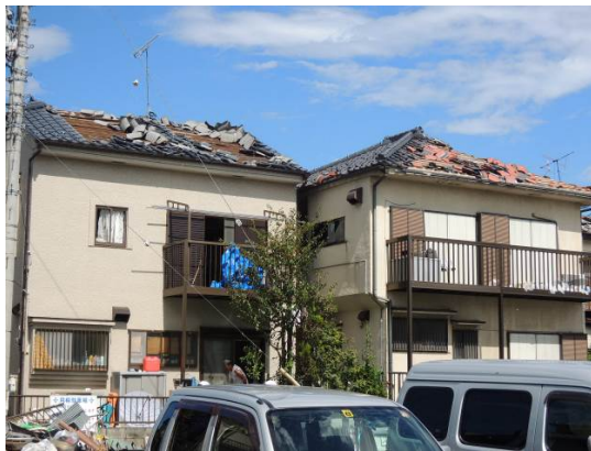
写真11 粘土瓦の脱落（越谷市）
