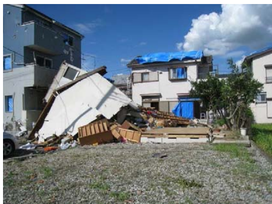
写真1 上部構造の倒壊（越谷市）
