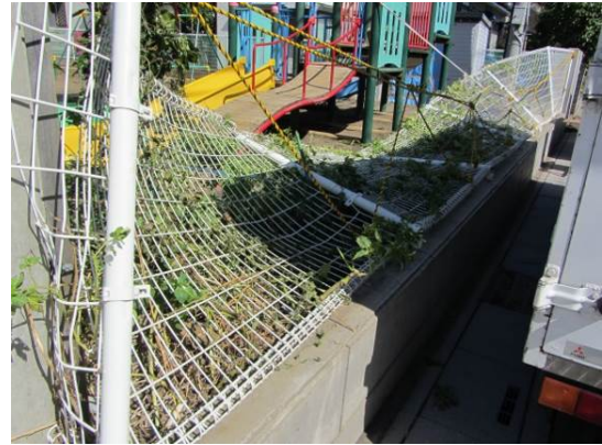
写真25 鋼製コンテナの転倒（越谷市） 写真26 フェンスの倒壊（越谷市）
