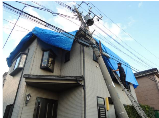
写真27 電柱の傾斜（越谷市） 写真28 電柱の折損（越谷市）
