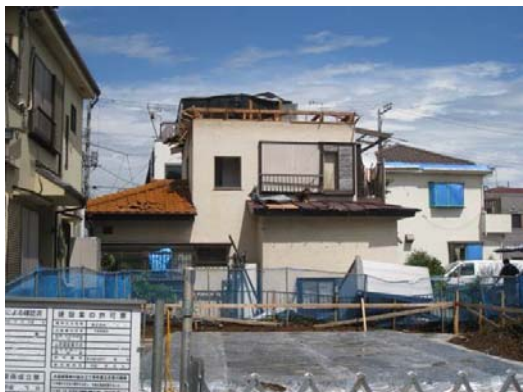
写真5 小屋組の被害（越谷市）
