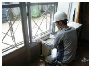
飛散防止フィルムの 工事の様子
