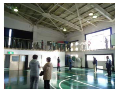
支援例: 学校関係者等による 非構造部材の耐震点検
