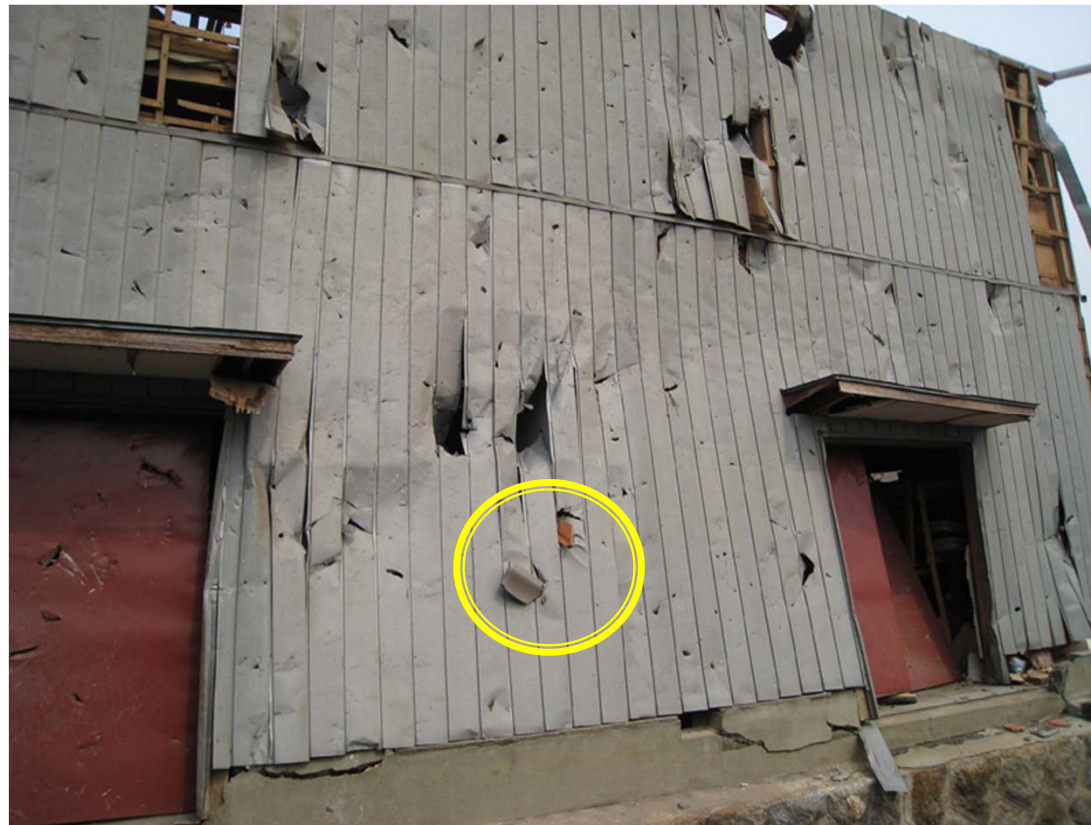
飛来物 外壁に突き刺さった瓦 板硝子協会5月8日撮影
