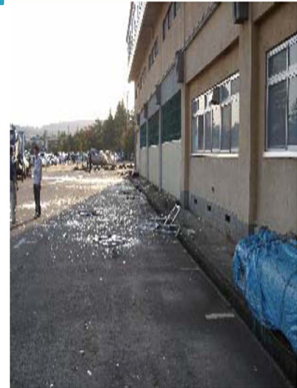
2004年10月23日新潟県中越地震の被害調査(20041024) 加藤大介氏(新潟大学)、本多良政氏(新潟大学大学院)より
