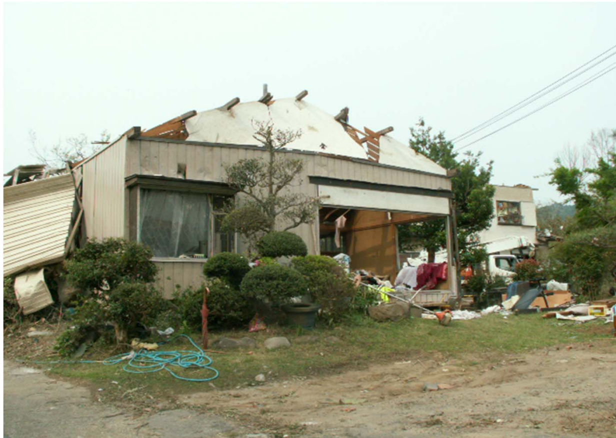
屋根が吹き飛ばされた家屋 板硝子協会5月8日撮影
