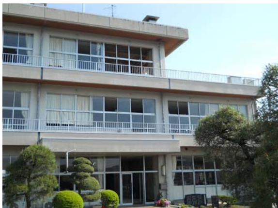
↑ 校舎ガラス破損状況
