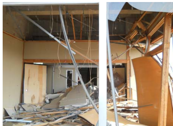
↑ 校舎内被害状況
