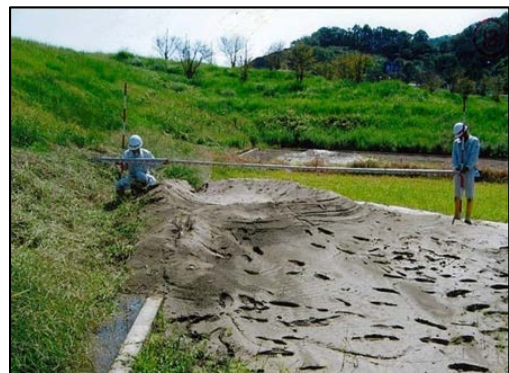
洪水時の堤防等の漏水
