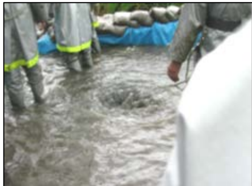
洪水時の堤防等の漏水
