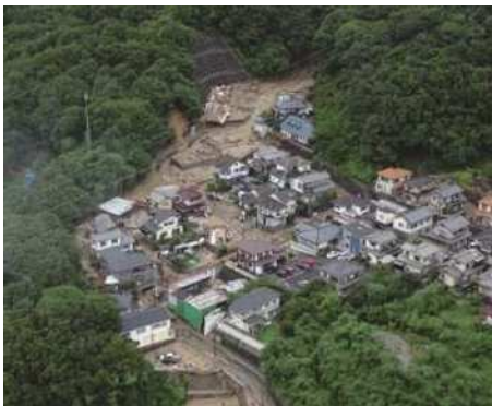
図-4 安芸区矢野東の土石流
