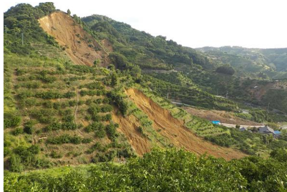
土砂崩れ（吉田町）
