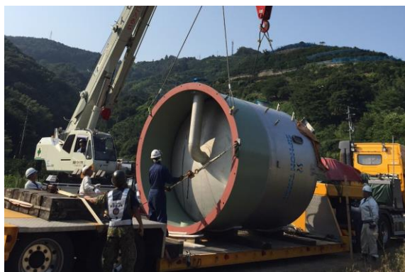
浄水器の搬入（吉田浄水場）
