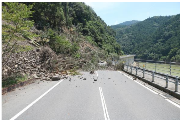
土砂崩れ（野村町）
