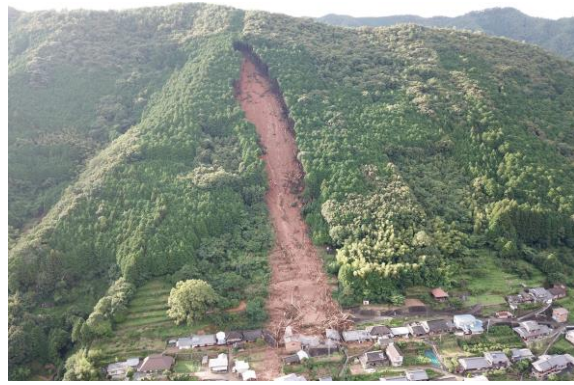
土砂崩れ（宇和町）
