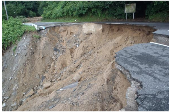
道路崩壊（県道 49 号大島環状線）
