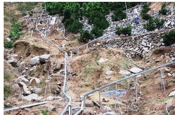
果樹園地での土砂崩れ（松山市怒和島）
