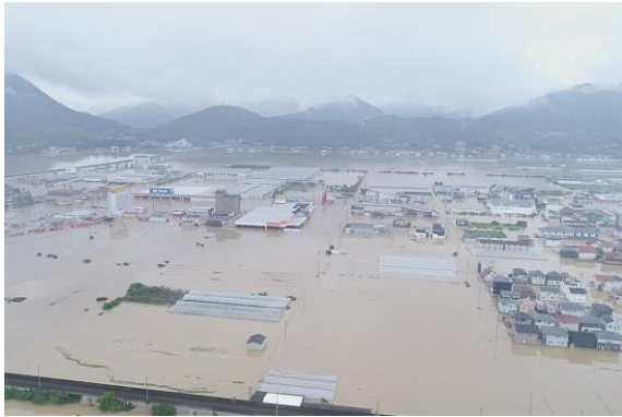
冠水（市内ドローン空撮）
