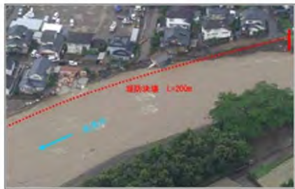
浸食により家屋が流失した状況
