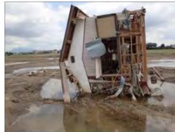
堤防決壊による家屋の倒壊
