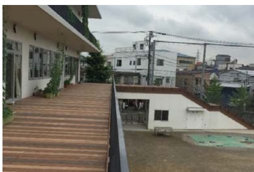
図 10 テラスと繋がっている階段
