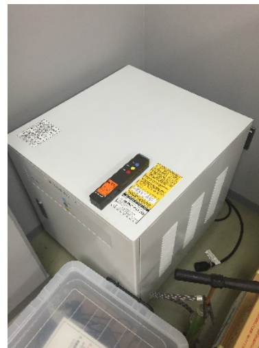
蓄電池(体育館内)
