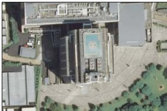
屋上ヘリポート(H)の例(足立区役所)
