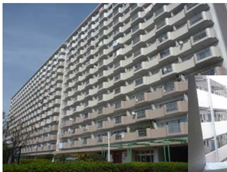
一時避難施設の例3(URが管理する賃貸住宅)
