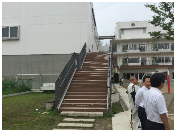
体育館と校舎に接続している階段
