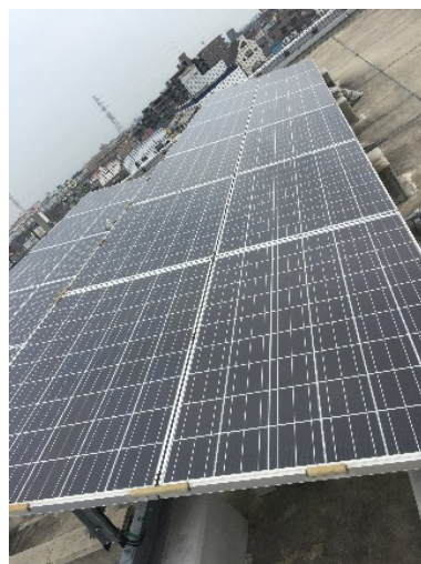
太陽光パネル(屋上)
