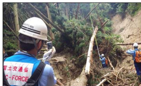
図 24 土砂災害危険箇所の現地調査 (国土交通省提供)
