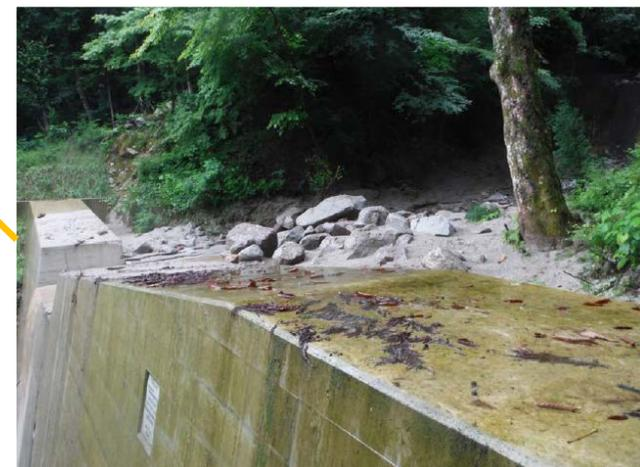
崩壊土砂を捕捉するとともに、拡大侵食を防止した治山ダム
