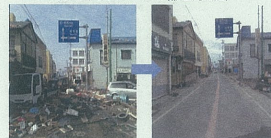
(相馬市内のガレキ撤去状況)
