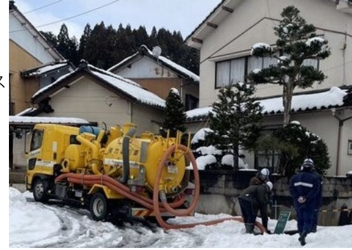
能登町 バキューム車により下水処理場へ運搬
